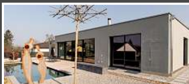
Ersatzneubau in Obfelden
